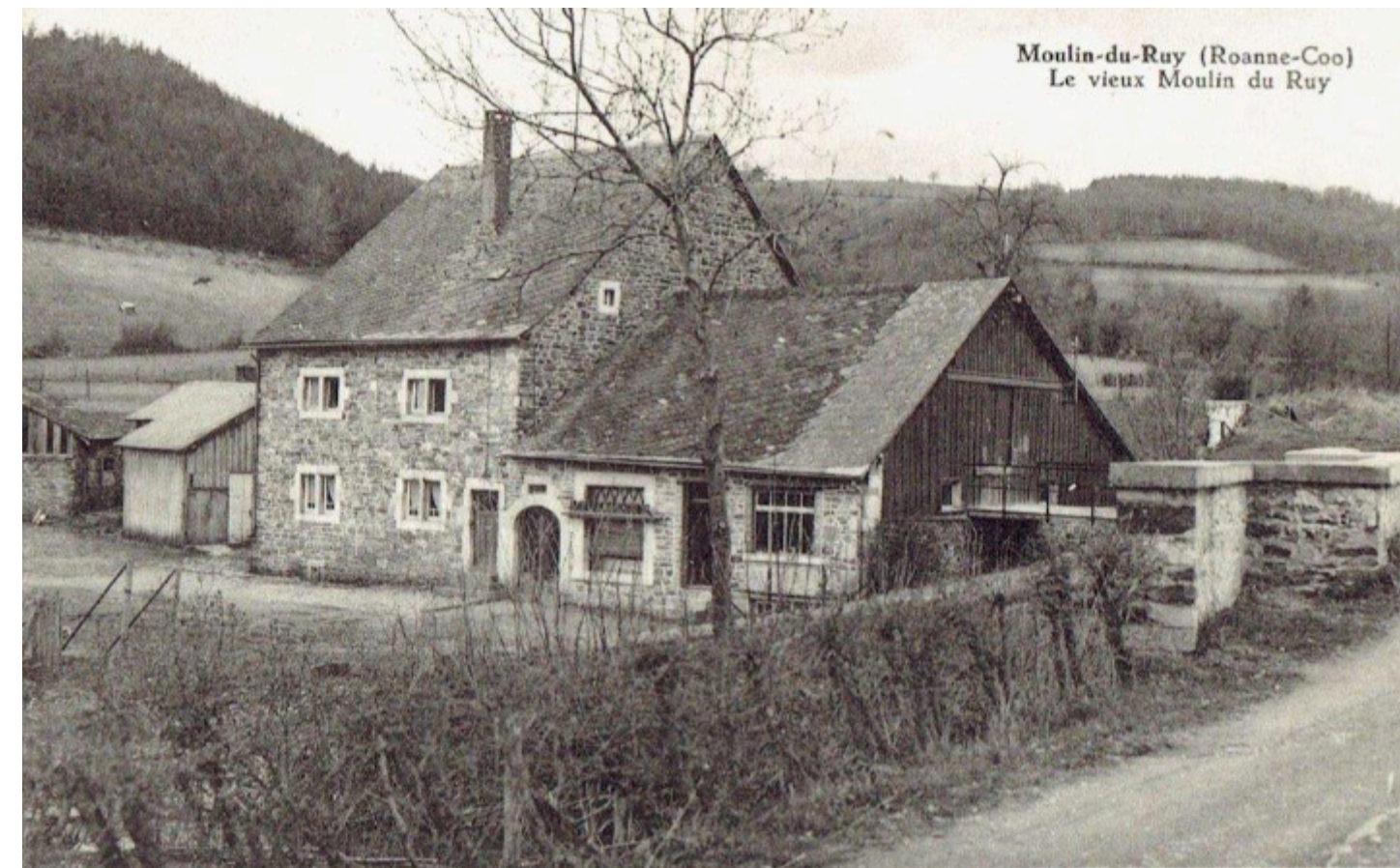
Le moulin à aubes du village de Moulin du Ruy existait probablement depuis 1529 permettait à tous les habitants de venir faire moulinner leurs récoltes. En 1917, son propriétaire transforma le moulin afin qu'il produise de l'électricité stockée sur batterie et redistribuée aux villageois via une ligne en zinc. Le moulin arrêta de tourner vers 1950 et est aujourd'hui reconverti en gîte.
