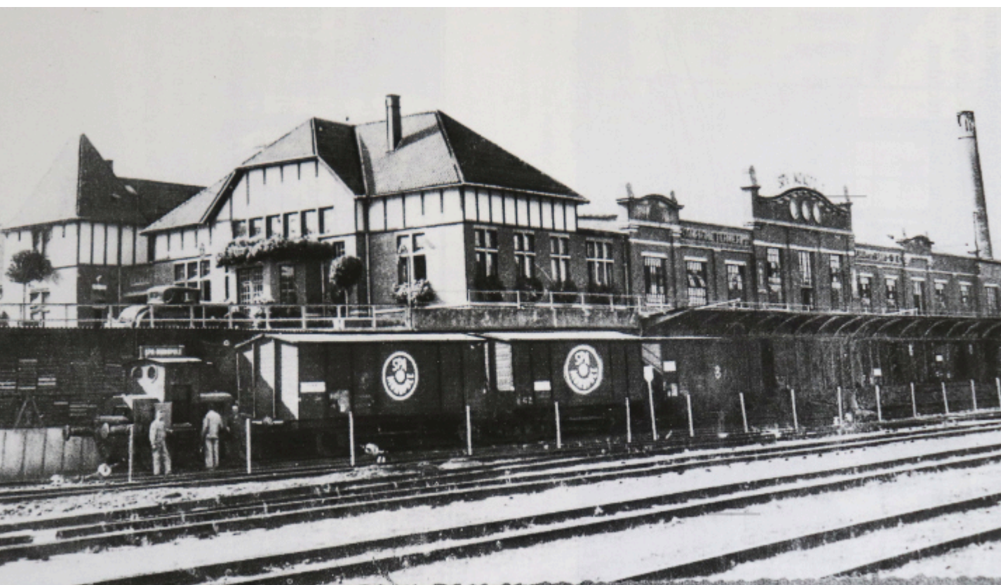
Nouvelle usine construite en 1924 le long du chemin de fer (Henrard, 1999)
