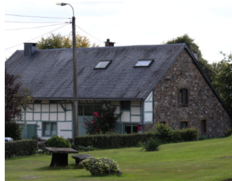
Ferme unifaïtière à deux niveaux présentant une asymétrie suite à son extension arrière. Elle dispose d'un auvent ainsi que d'une façade à colombage
