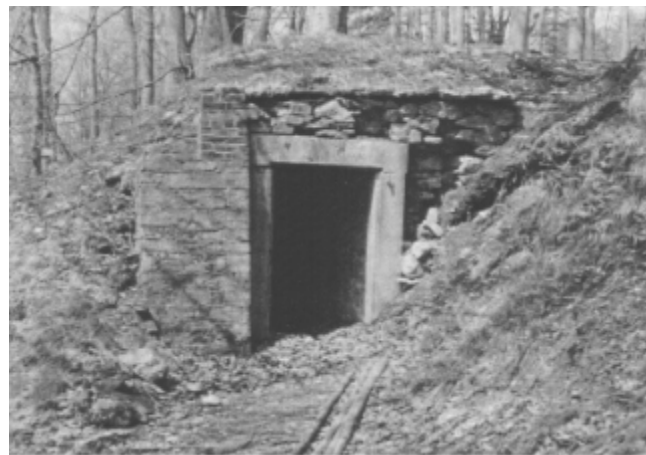
Glacière de la Sauvenière: la conservation des aliments nécessaires aux nombreux curistes était permise grâce aux glacières alimentées en glace naturelle. Pour une bonne isolation du bâtiment, celui-ci était enterré et permettait de conserver la glace jusqu'à la période estivale. © Musées de la Ville d'eaux - Spa
