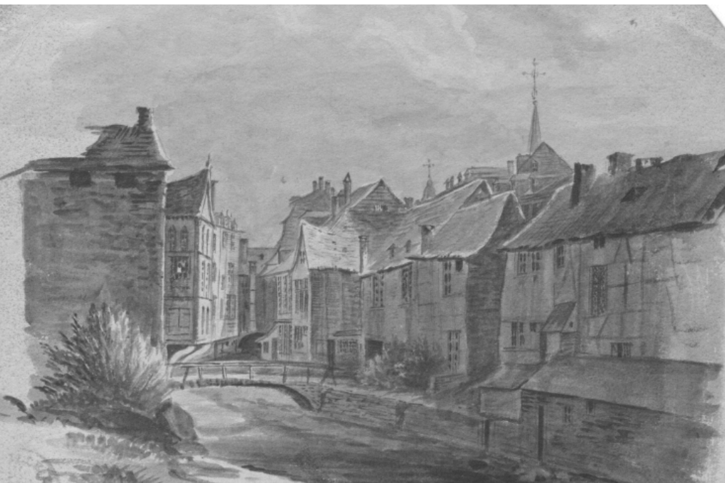
Le Wayai avant sa couverture dans sa traversée urbaine. © Fonds Body - Spa.
