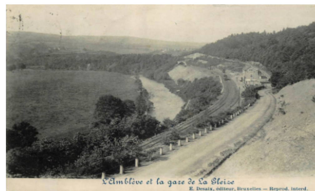
La station de La Gleize était située en fond de vallée, à 2,5km du village, à proximité de l'actuel parc à conteneurs (Demeulder, 2022)
