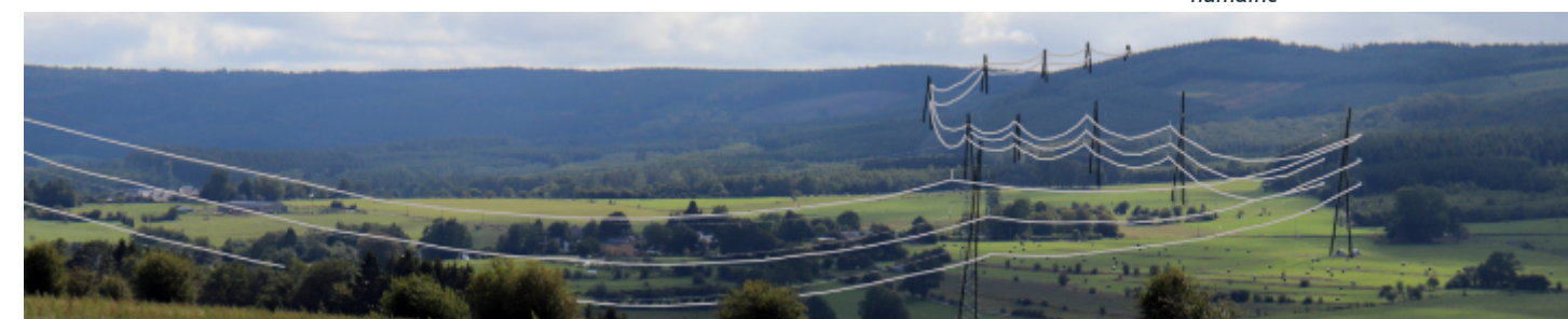
Photo-croquis : mise en évidence de la traversée de la vallée par une ligne haute tension
