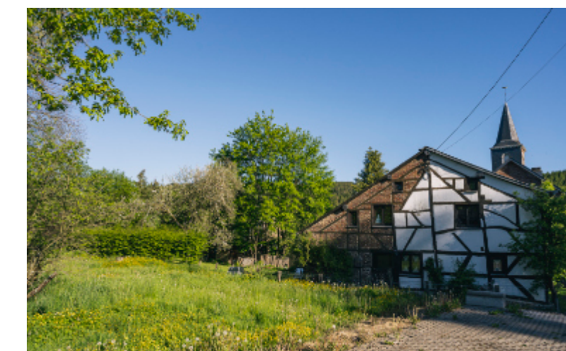
Maison à colombages avec brique apparente et enduit
