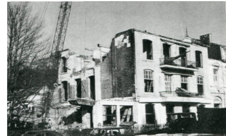
Démolition de l'Hôtel Rosette situé avenue Reine Astrid © Coll. privée Reynaerts D.
